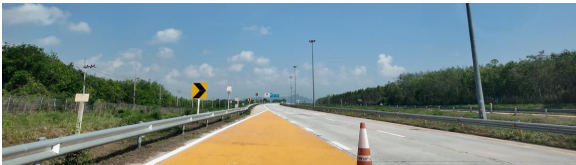
รูปที่ 6-3 สภาพปัจจุบันทางหลวงพิเศษระหว่างเมืองหมายเลข 7 ช่วงประมาณ กม.140+600
