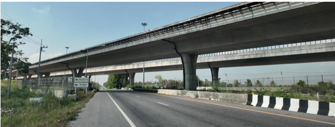
รูปที่ 6-15 สภาพทางหลวงหมายเลข 331 บริเวณพื้นที่โครงการ
