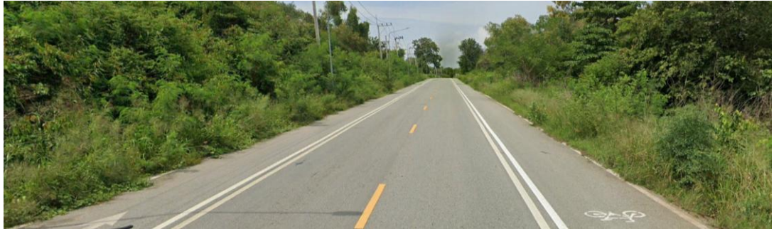
รูปที่ 6-24 ทางหลวงชนบท ขบ.1008
