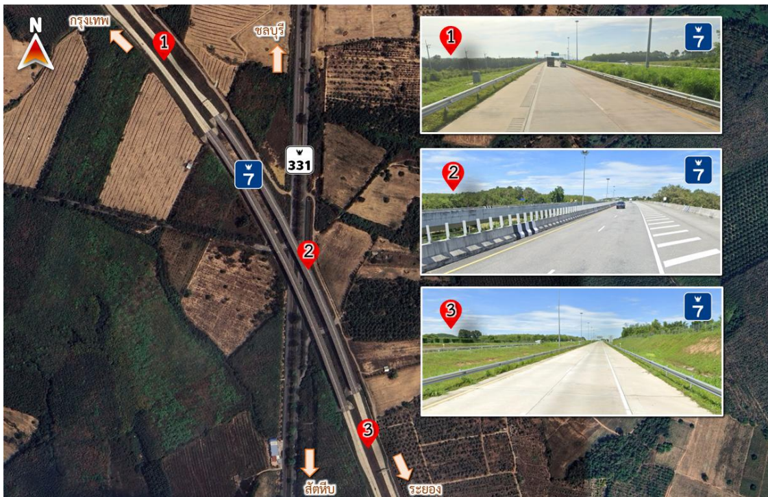
รูปที่ 6-1 สภาพปัจจุบันของทางหลวงพิเศษระหว่างเมืองหมายเลข 7 บริเวณที่ตั้งโครงการ
