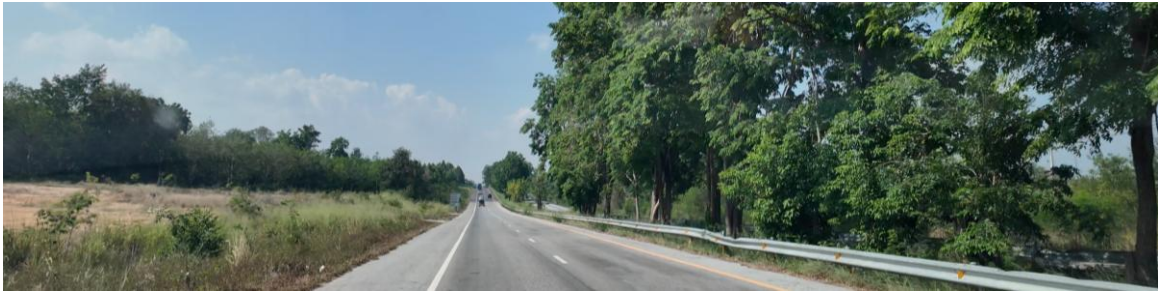
รูปที่ 6-14 สภาพทางหลวงหมายเลข 331 บริเวณผ่านจุดตัดทางหลวงพิเศษระหว่างเมืองหมายเลข 7 ไปทางทิศใต้ ทิศทางไปสัทธิบ
