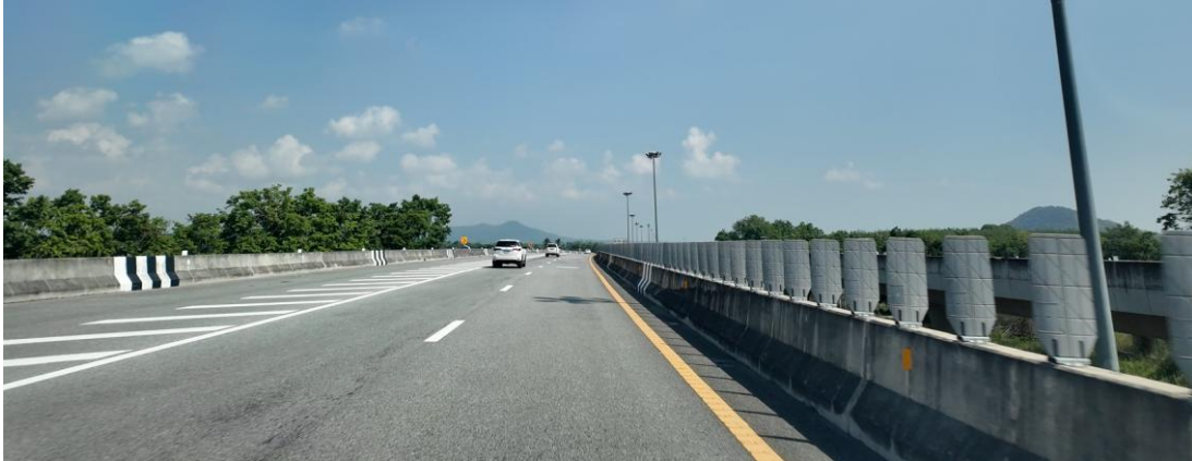
รูปที่ 6-8 สภาพทางหลวงพิเศษระหว่างเมืองหมายเลข 7 บริเวณจุดตัดโครงการ
