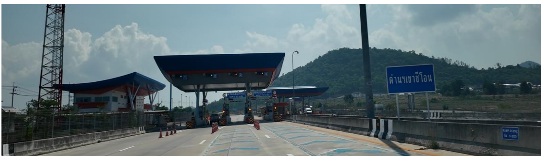
รูปที่ 6-7 สภาพปัจจุบันทางหลวงพิเศษระหว่างเมืองหมายเลข 7 ช่วงประมาณ กม.143+300
