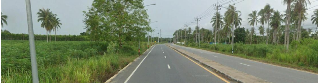
รูปที่ 6-27 ทางหลวงชนบท ขบ.2081
