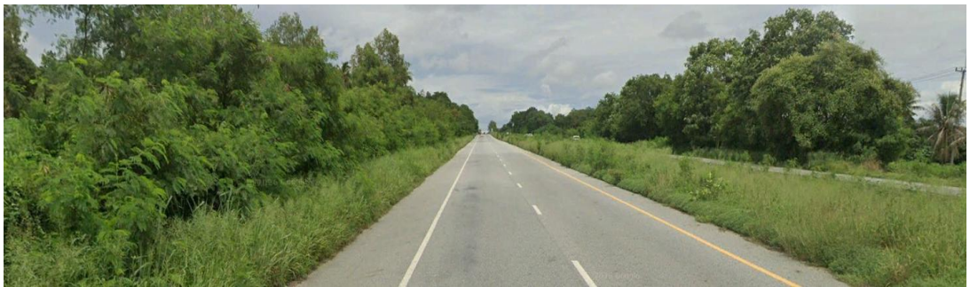
รูปที่ 6-20 ทางหลวงแผ่นดินหมายเลข 331
