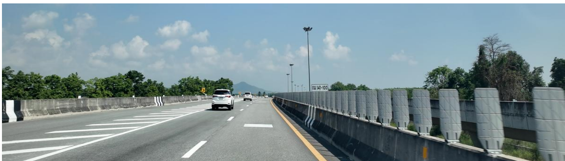
รูปที่ 6-4 สภาพปัจจุบันทางหลวงพิเศษระหว่างเมืองหมายเลข 7 ช่วงประมาณ กม.141+175
